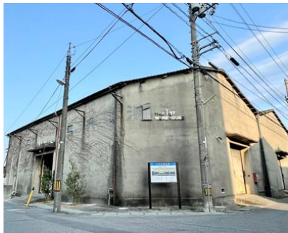
第一倉庫 (シェアショップ&オフィス)
