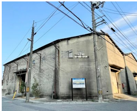
第一倉庫 (シェアショップ&オフィス)
